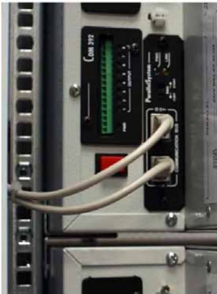
Параллельное подключение и плата контактов программируемых реле
